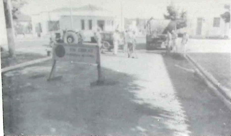
A Operação "Tapa-Buracos" beneficiou todas as vias pavimentadas de Bela Vista
