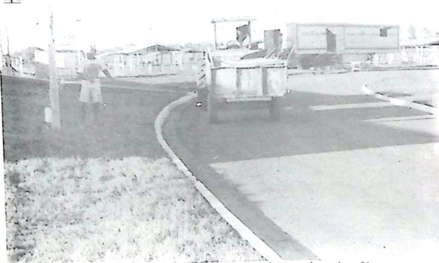
Outra equipe executou todo o serviço de pintura de meios-fios e postes - de iluminação
