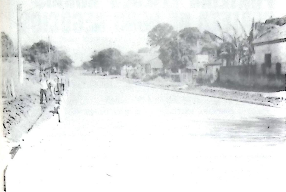
A implantação dos meio-fios já começou pela Rua Barão do Ladário
