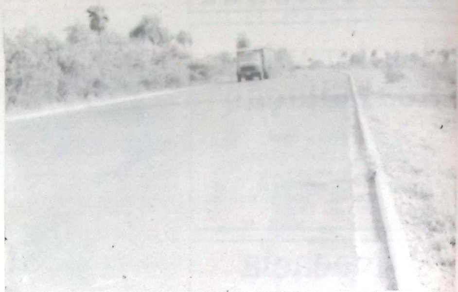
Vista da BR 060, que recebeu as obras de asfaltamento no Governo Pedro Pedrossian
