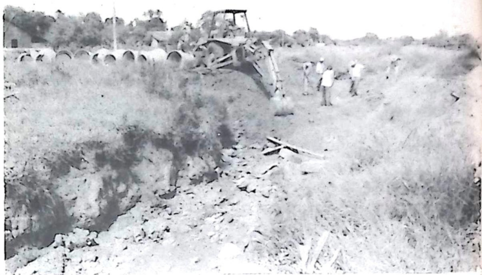
Uma equipe da Secretaria de Obras faz a implantação de novas tubulações na Baixada Fluminense
