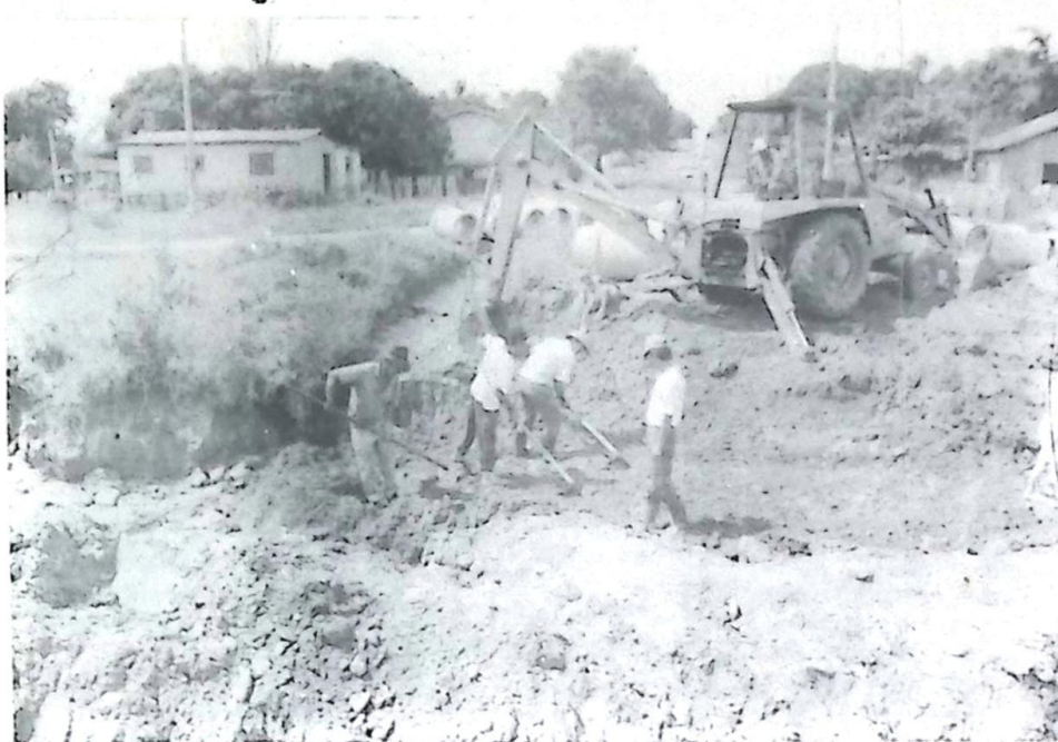
Máquinas e homens da Prefeitura trabalham nas ruas mais estragadas pelas águas das chuvas
