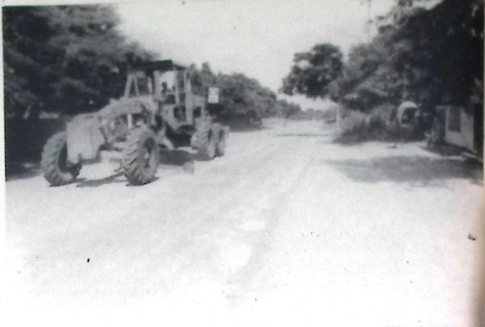
A Motoniveladora da Prefeitura Municipal trabalha em ritmo acelerado na recuperação das ruas da cidade
