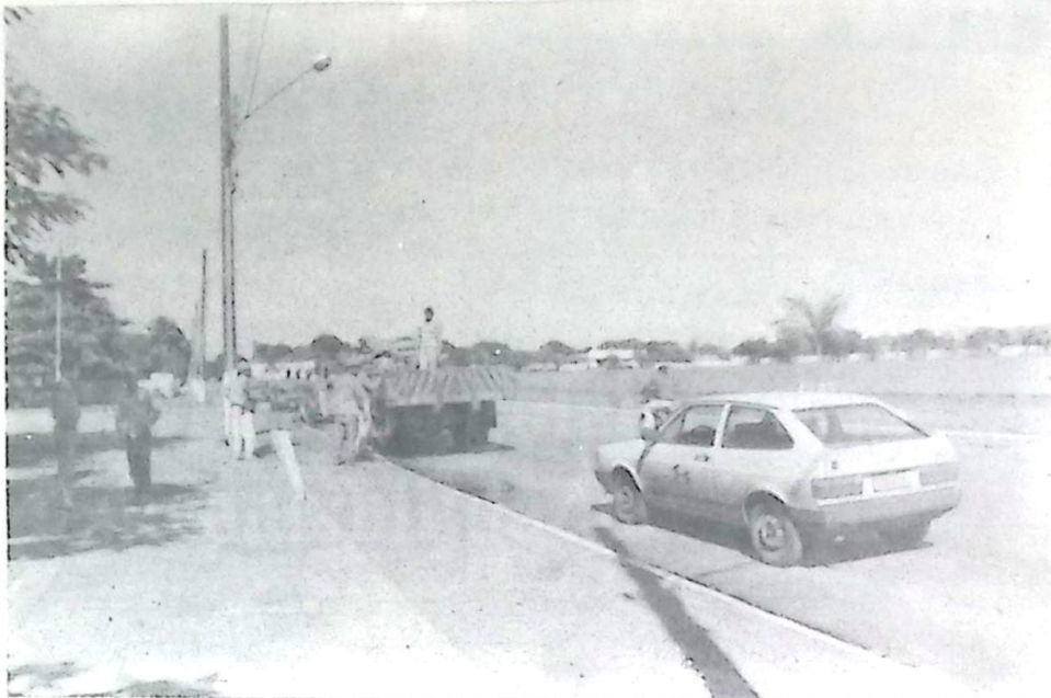
As melhorias na rede elétrica da Rua Santo Afonso vai beneficiar dezenas de consumidores e outros setores da cidade
