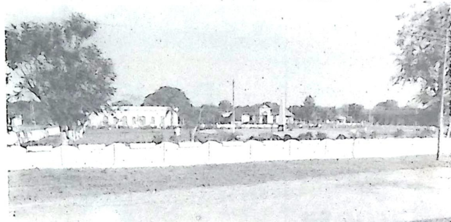
Vista da Praça de Los Heroes, que recebeu benfeitorias como pintura, limpeza completa e construção de quase 2.000 metros quadrados de calçada
