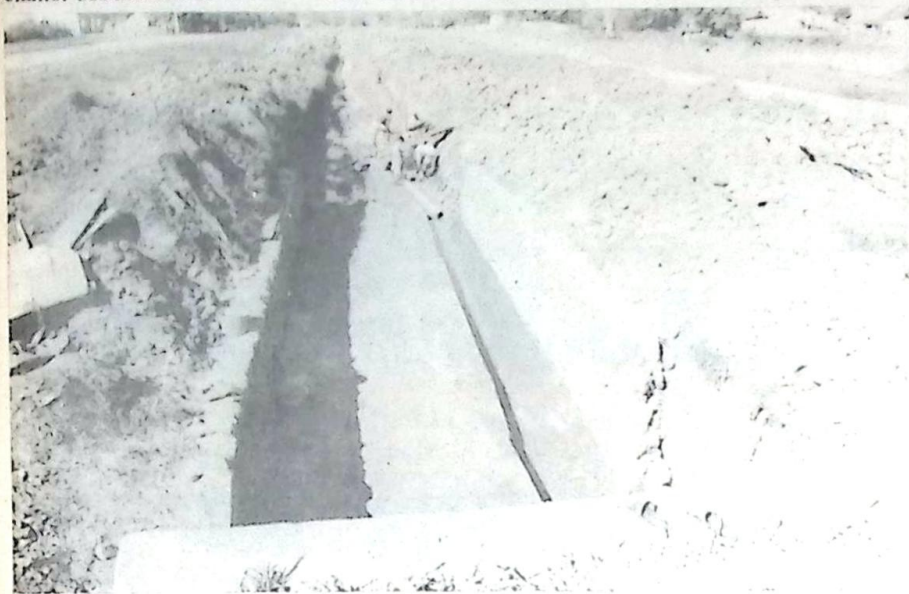
A execução da obra também vai acabar com as inundações que atormentavam os moradores da Baixada Fluminense
