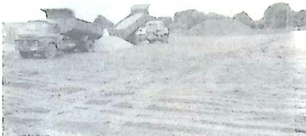
Materiais para a Pavimentação Asfáltica sendo depositados no Bairro Vila Nova
