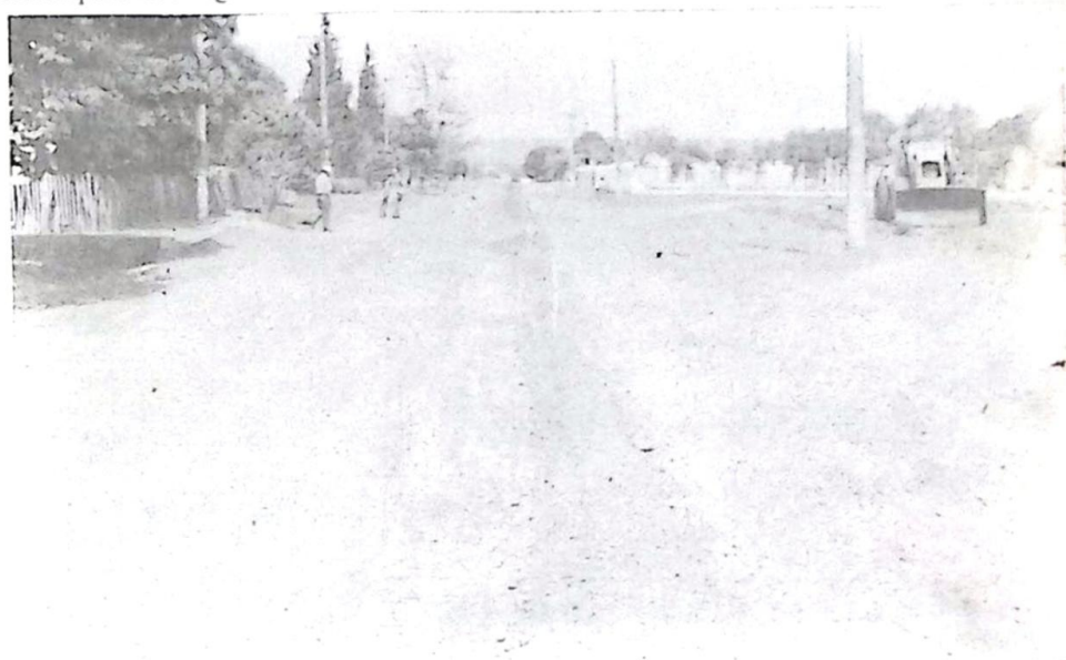
Todas as Ruas do Bairro serão beneficiadas com a pavimentação asfáltica
