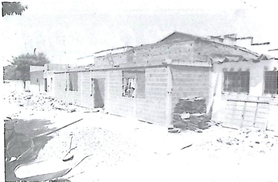
As obras de ampliação e modernização do Clube estão sendo executadas em ritmo acelerado
