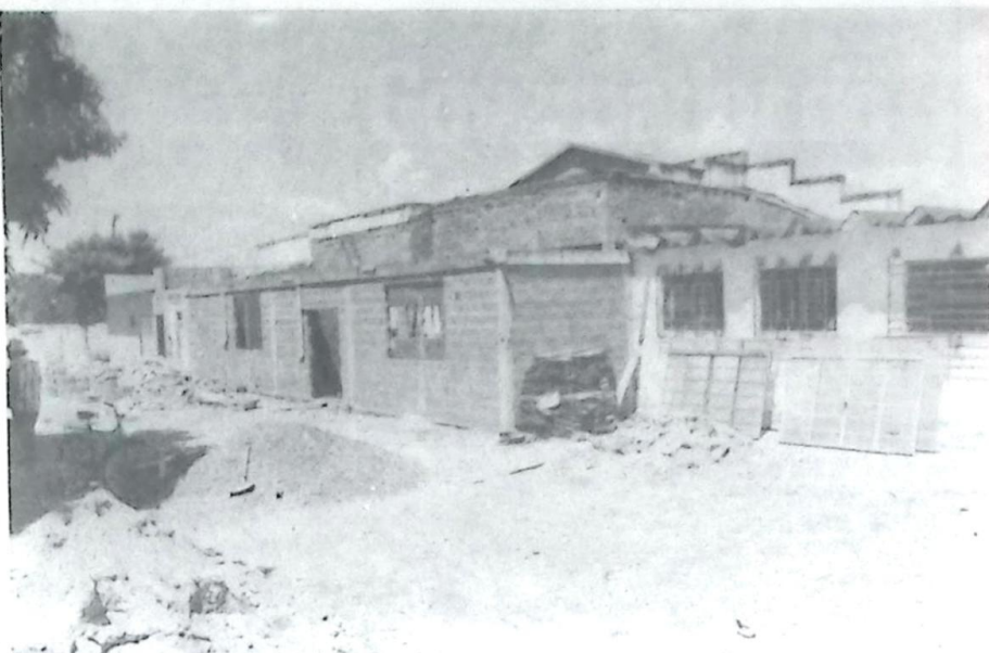
Vista da parte de trás do GPR, onde estão sendo construídas as novas dependências da Administração do Clube
