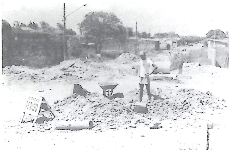
Vista das obras de canalização e drenagem realizadas na Rua Eduardo Peixoto
