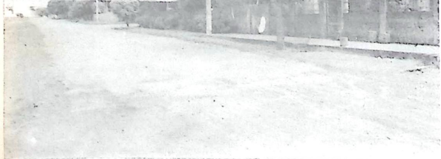
Contando com apenas recursos próprios, a Prefeitura executa a pavimentação asfáltica na Vila Nova
