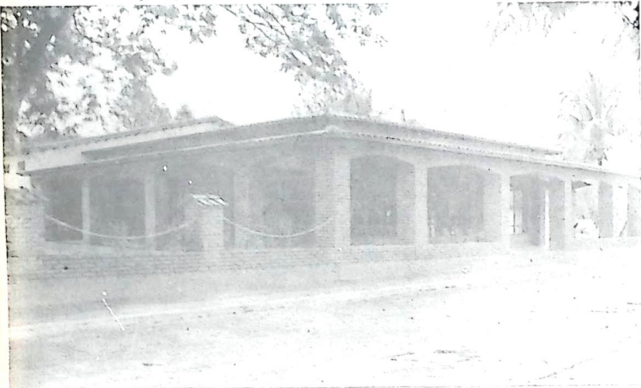
Vista da nova sede do CORAJ
