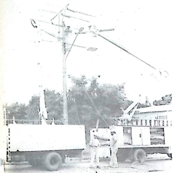
Diversos pontos da rede de distribuição de energia...
