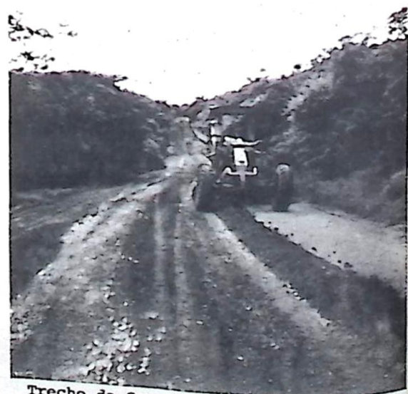
Trecho da Serra da Rodovia MS-166, Antonio João/Bela Vista
