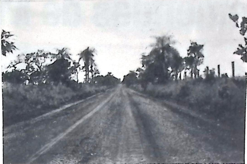
Trecho da estrada vicinal da localidade do Mosquiteiro - patrolada e cascalhada
