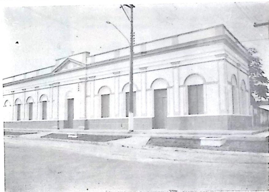
Vista do majestoso prédio do 3º Pelotão PM, totalmente reformado através de convênio entre a Prefeitura Municipal e a Secretaria de Estado de Segurança Pública
