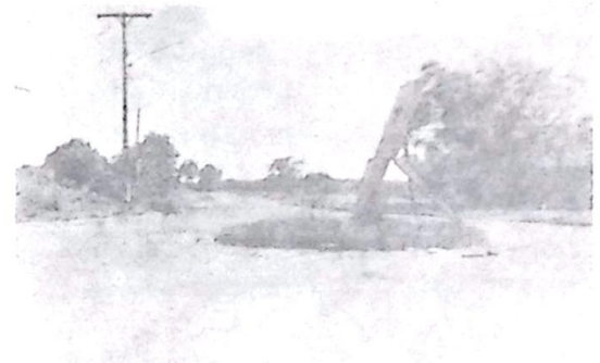
No coração da cidade, o marco da pavimentação asfáltica da Av. Brasil, construída no Governo do Dr. Pedro Pedrossian encontra-se em total abandono
