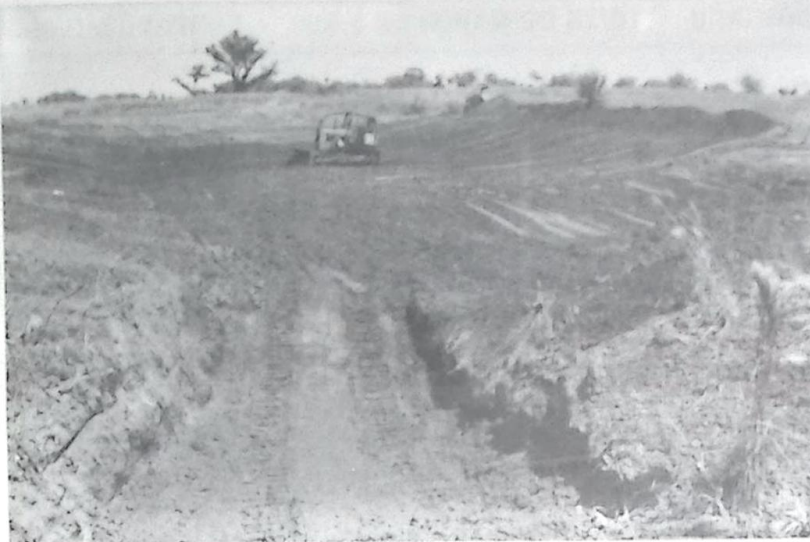
Vista do local onde está sendo construído o aterro sanitário de Bela Vista
