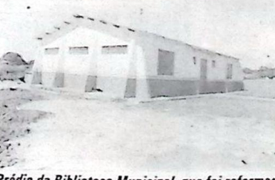
Prédio da Biblioteca Municipal, que foi reformado
