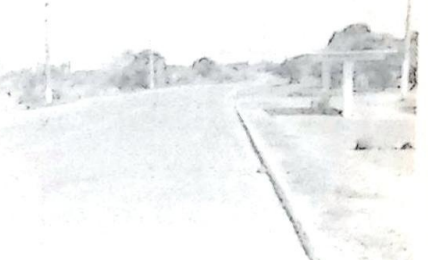
Ponto de Ônibus construído no prolongamento da Rua Barão do Ladário
