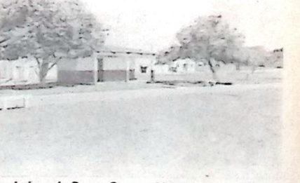
Banheiros da Praça Castro Alves, recuperados
