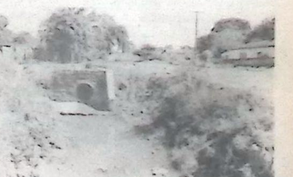
Diversos bueiros foram instalados na cidade
