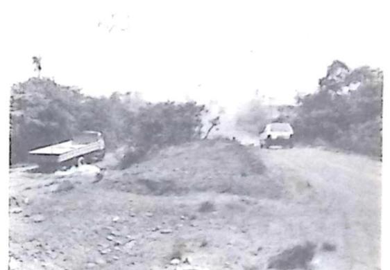
A maior parte dos veículos pesados estão transpondo o córrego por água para evitarem o perigo de despencarem da ponte
