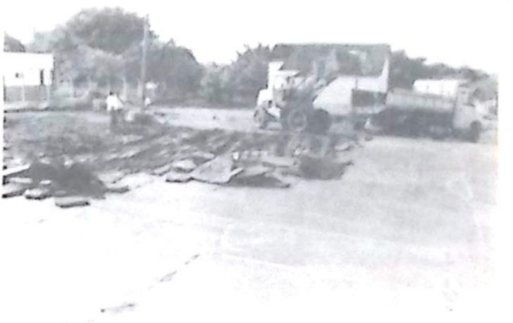
Nas fotos maquinários da Secretaria de Obras fazem a preparação do terreno para a construção do Centro de Múltiplas Atividades
