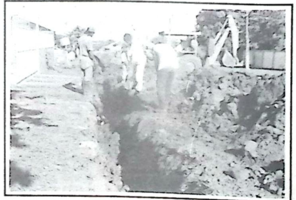
Expansão de rede de esgotamento sanitário
