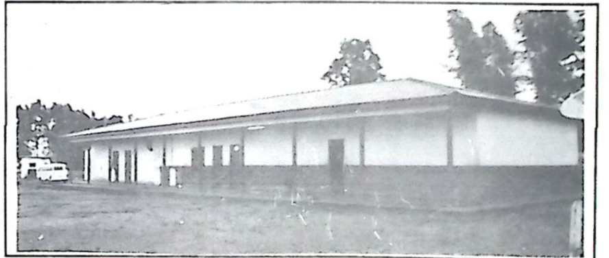
Construção de salas de aula no Assentamento Barra do Itá
