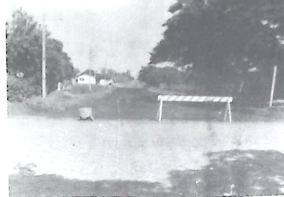
... estão todas sendo asfaltadas, acabando com o transtorno da poeira
