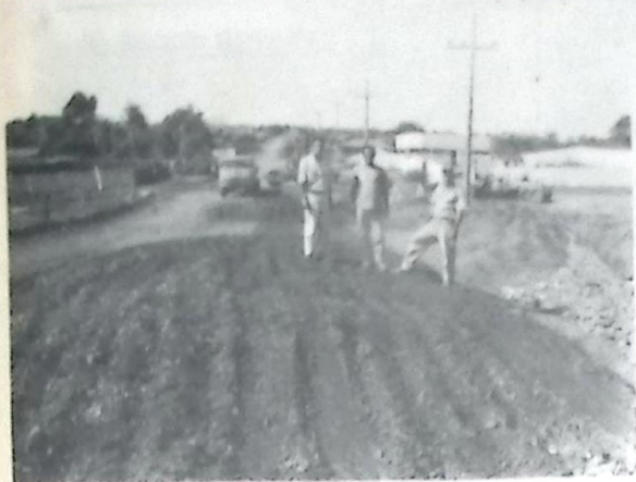
Dilmar visitando obras de pavimentação
