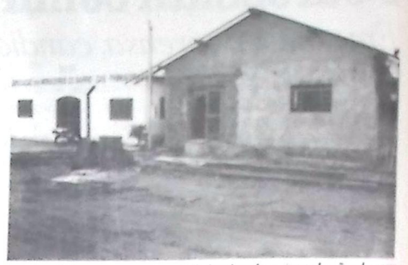
Ao lado o anexo que será destinado a instalação de um Posto de Saúde
