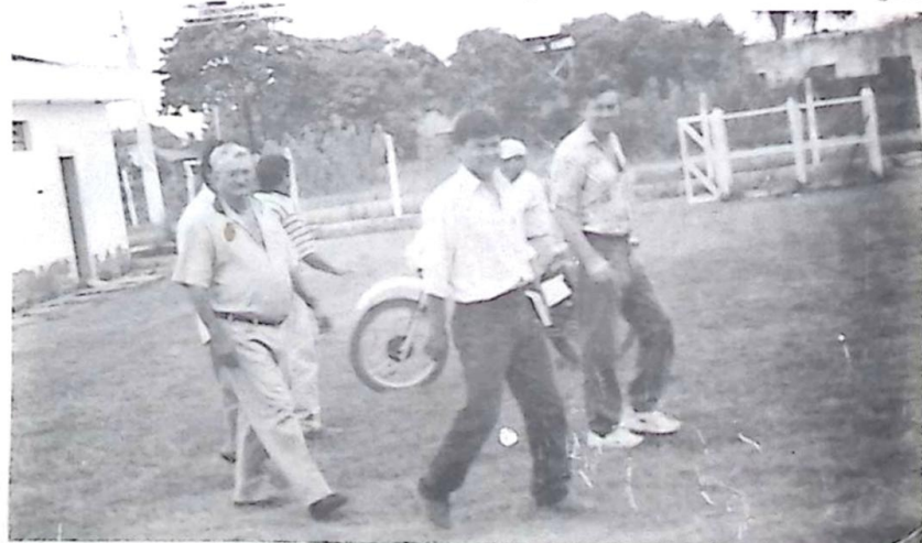
Os Vereadores liderados pelo Presidente, Ailton Sanches, mostraram a preocupação com relação a manutenção do Sistema de Tratamento e Distribuição de água para a comunidade murinhense
