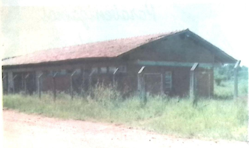
Antes do prefeito Dilmar: Centro de Saúde, fechado e abandonado
