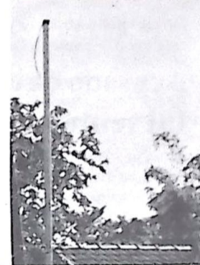
No detalhe o padrão novo, com os fios pendurados, sem nenhuma ligação com a rede elétrica
