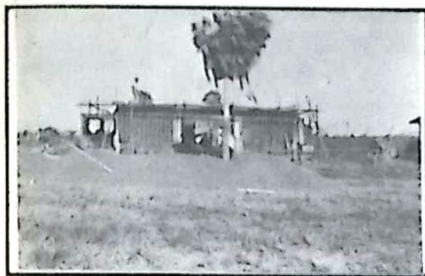
Centro de Convivência dos Idosos (em obras)
