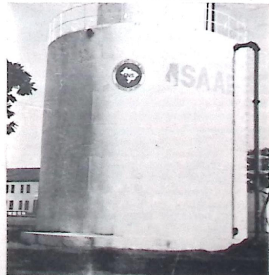
O novo Reservatório do SAAE, localizado ao lado do campo de Pólo do 10º RC Mec
