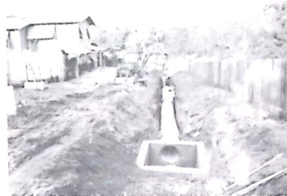
Obras de canalização na Rua XV de Novembro, em execução
