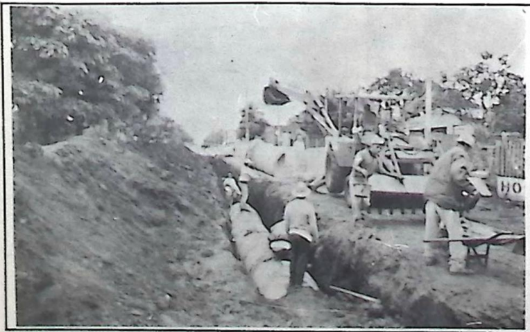
Operários fazem preparativos para asfaltamento de ruas em Antonio João
