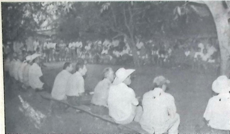
Dezenas de moradores do "Nunca-Te-Vi" receberam com alegria a chegada dos materiais para a eletrificação do Distrito
