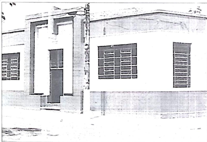
Vista do prédio da Câmara Municipal, totalmente revitalizado e pintado nas cores da Bandeira do Brasil
