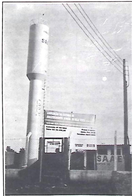
Vista do novo reservatório de água construído no bairro Água Doce
