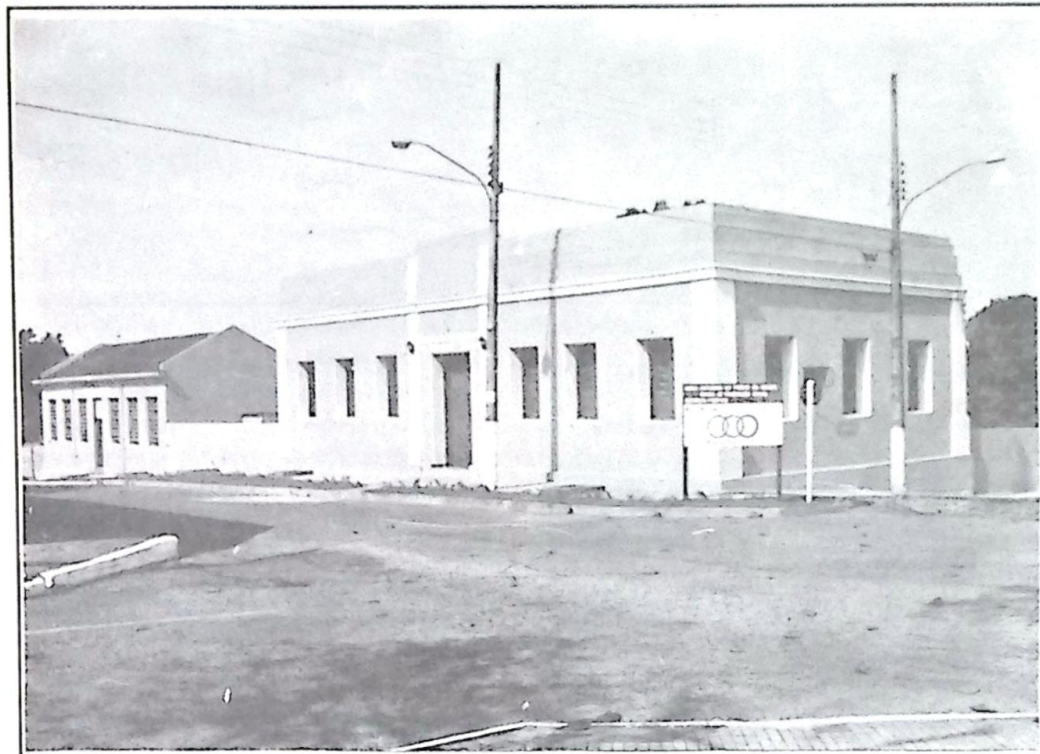
Prédio construído por volta de 1909, primeiras instalações da Cadeia Pública Municipal, Delegacia de Polícia e Coletoria Estadual, mais tarde, em 1938, abrigou o antigo Grupo Escolar Generoso Ponce. Nos últimos tempos se encontrava totalmente abandonado. Agora é a nova sede da Secretaria Municipal de Promoção Social, em seu anexo funciona a Oficina de Cursos da Secretaria
