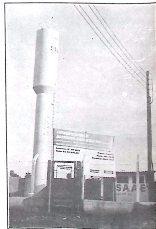
O serviço de fornecimento de água de Bela Vista, hoje sob total responsabilidade da Prefeitura Municipal, é um dos melhores do Estado, atende quase 100% da população urbana do município, graças a obras como a construção de um novo reservatório, que vai atender a região do Bairro Água Doce e adjacências. Diversos serviços de expansão de redes também vêm sendo realizados nos bairros, levando água a muitas famílias que não eram atendidas.
