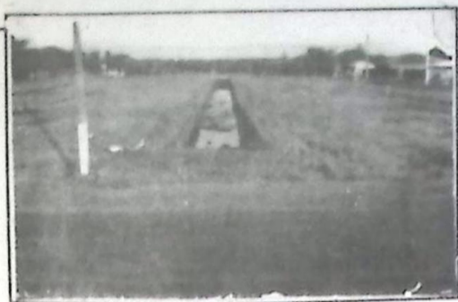
Implantação de galerias de água pluviais, com calçamento de vala, na Baixada Fluminense
