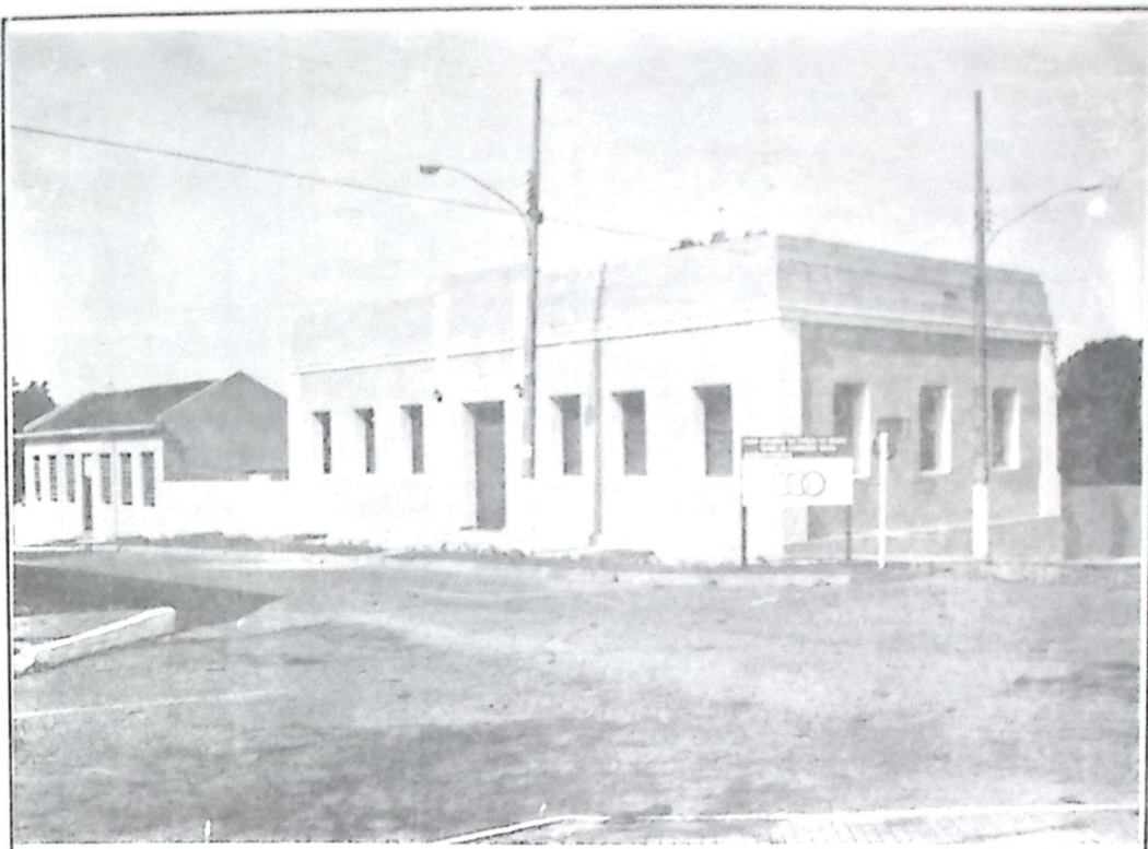
Prédio construído por volta de 1909, primeiras instalações da Cadeia Pública Municipal, Delegacia de Polícia e Coletoria Estadual, mais tarde, em 1938, abrigou o antigo Grupo Escolar Generoso Ponce. Nos últimos tempos se encontrava totalmente abandonado. Agora é a nova sede da Secretaria Municipal de Promoção Social, em seu anexo funciona a Oficina de Cursos da Secretaria (à esquerda).
