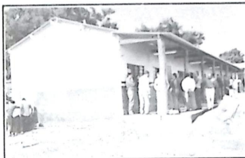
Uma conquista das mais relevantes na área da Educação, pela atual administração, foi a Extensão da Universidade Federal para nossa cidade. Na foto, vista lateral da ampliação executada pela Prefeitura na Escola Jarbas Passarinho, para abrigar os cursos da UFMS.
