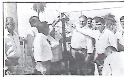
Registro da inauguração da rede de eletricidade para o Distrito N° S° de Fátima, Pirapóca, bairros da Cancha e Serradinho, obra de extrema importância para os pequenos produtores e chacareiros, que foi reivindicada pela atual administração ao Governador Zeca do PT, antes do 2º turno das eleições para o Governo do Estado, em 1998
