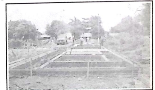
O alicerce para mais uma construção de moradia em Murtinho já está pronta. E o investimento na construção civil em Murtinho
