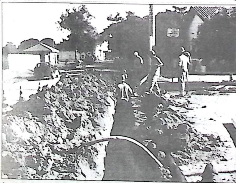
Instalação de cabos telefônicos por via subterrânea
