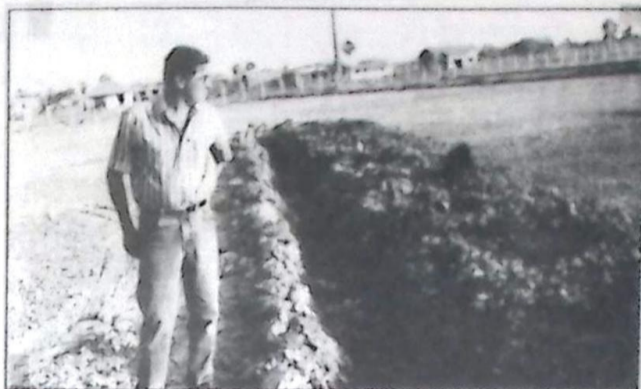
O Prefeito Abel Proença visitou o serviço de drenagem do Estádio Municipal.
