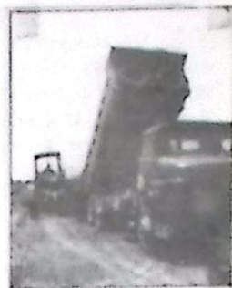
Maquinários trabalhando na recuperação do dique de contenção de enchentes
