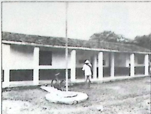
Reforma geral na Escola Rural da colônia Cachoeira
