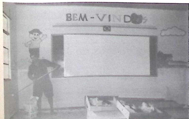
Sala de aula sendo toda remodelada para nossos alunos
