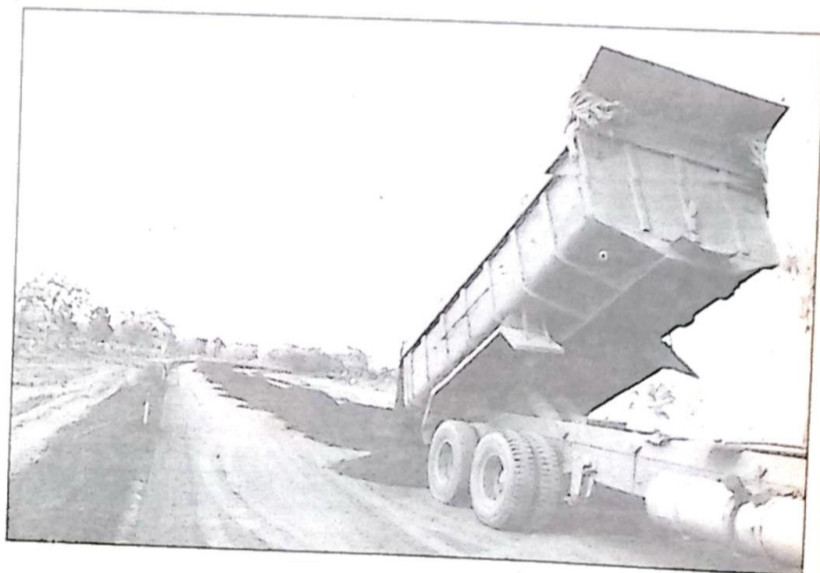
Pavimentação Asfáltica/ Antonio João
