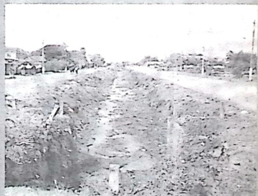
Entre os investimentos está a cobertura do valetão, junto a Avenida Paranjeiras
