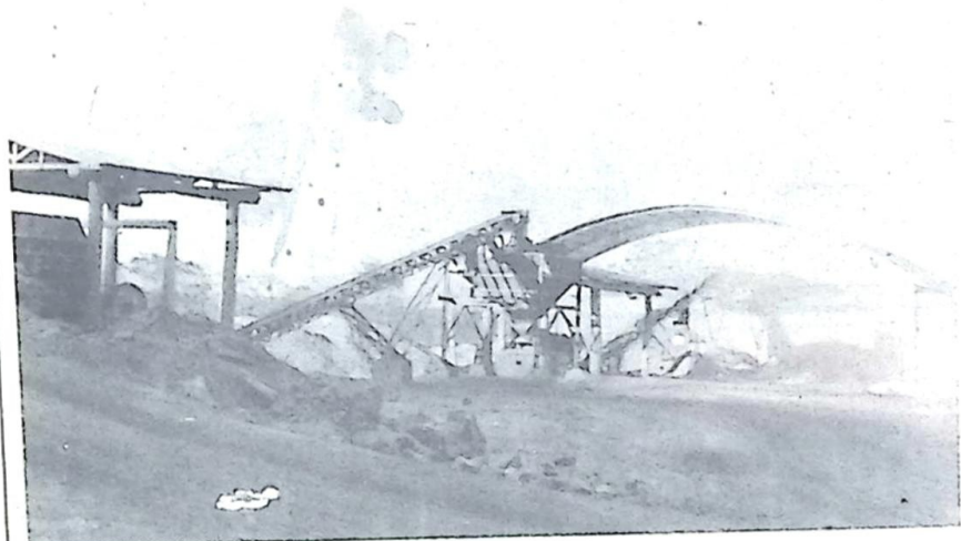
Vista parcial das instalações...
