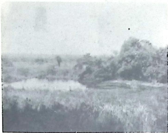
Vista parcial do açude.
