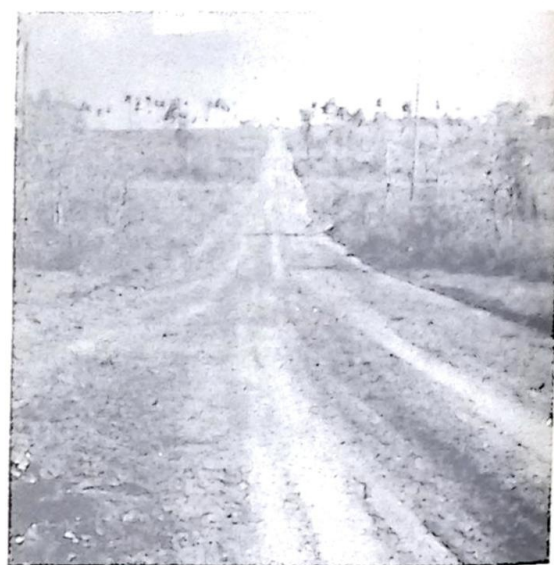
Estrada da Fazenda Sombrero (reformada pela Administração Castro Pinto).
